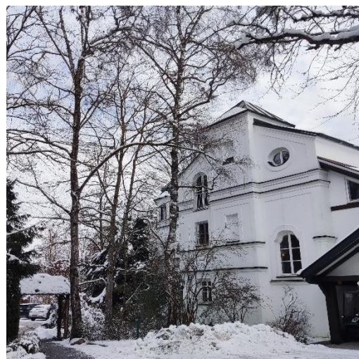
Abb. 12: Fußweg zum nordöstlichen Parkplatz vorbei an einem der Gebäude mit Patientenzimmern
