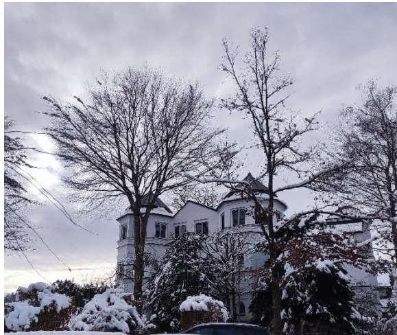
Abb. 10: Blick vom nordöstlichen Parkplatz auf die Patientenzimmer
