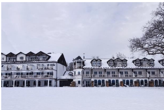
Abb. 11: Blick von Osten auf die Patientenzimmer und den Zentralbereich
