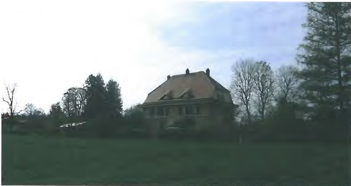
Abb. 6 Blick auf das im Untersuchungsgebiet vorhandene denkmalgeschützte Gebäude (Quelle: AGL, Mai 2012)
